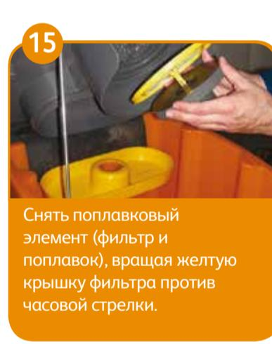
Снять поплавковый элемент (фильтр и поплавок), вращая желтую крышку фильтра против часовой стрелки.
